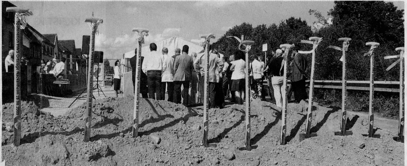
Mit dem ersten Spatenstich haben am Freitag die Bauarbeiten zur Anlage des Hochwasserschutzwalles begonnen.
